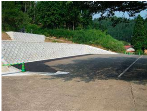
▲拡張工事が完了した駐車場
