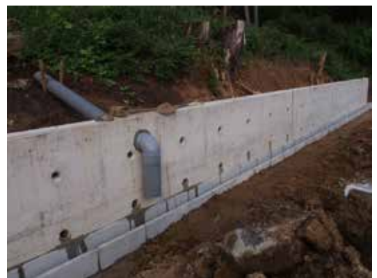
▲当初の計画にはなかった山側のコンクリート擁壁の工事
