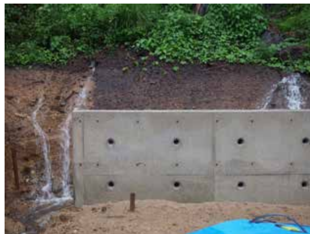
▲大雨による崩れを防ぐ為の擁壁
