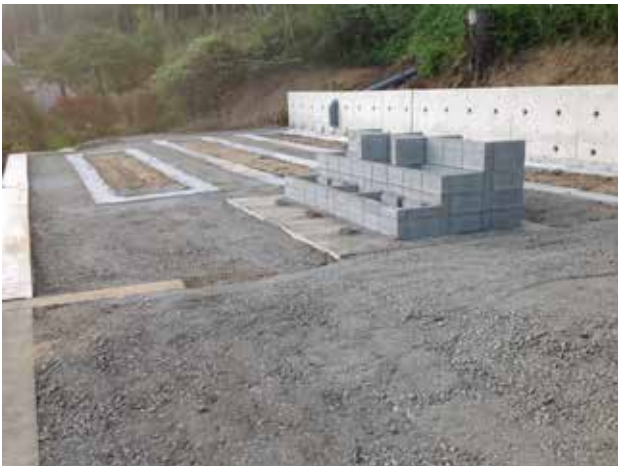
▲拡張造成工事のすすむ新たな霊園
