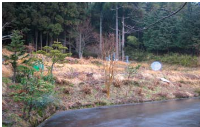
▲山側に向けて駐車場を拡張します。
