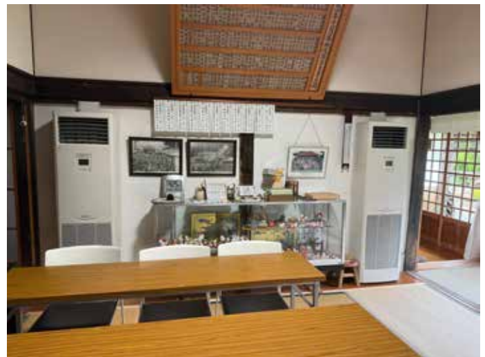
▲本堂東側に据え置きエアコンを2台設置
