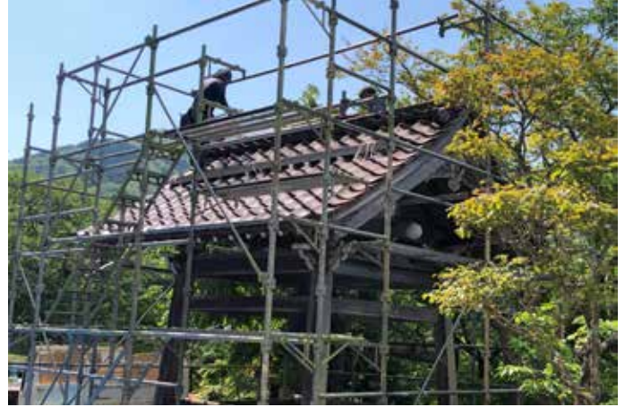
▲鐘楼屋根改修工事＝5月10日
